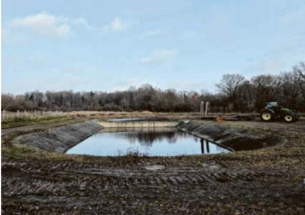
Am Regenrückhaltebecken hat Via Solutions Nord umfangreiche Unterhaltungsmaßnahmen durchgeführt. (Foto: Hainke)
